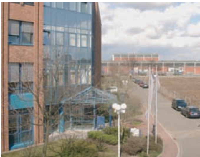
Die Hermann-Klammt-Straße, ausgebaut für die bessere Erschließung der Gewerbegebiete
