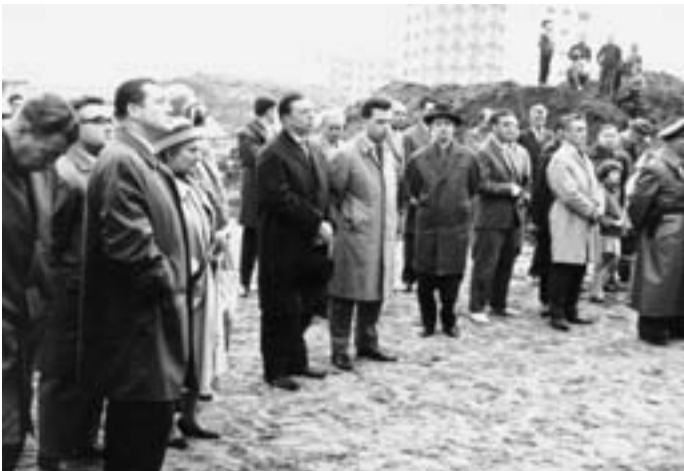
Spatenstich für ein Neubaugebiet mit Bürgermeister Kurt Kabermann (links)
