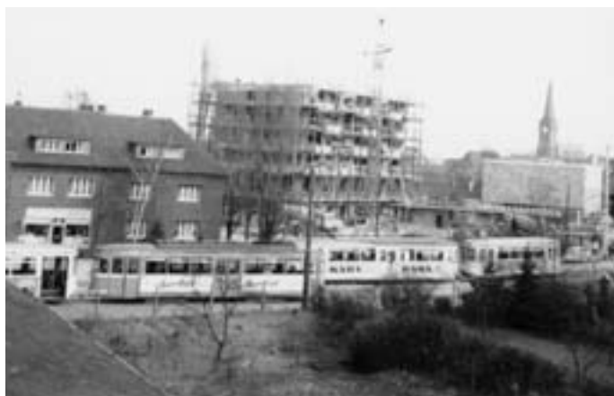
Größere Baumaßnahme auf der Kaarster Straße 1964
