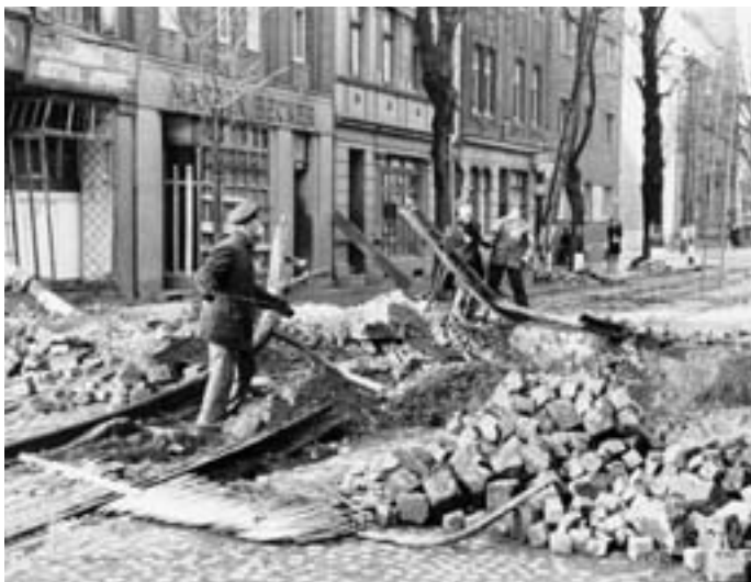
Further Straße nach dem Luftangriff vom 5.1.1944
