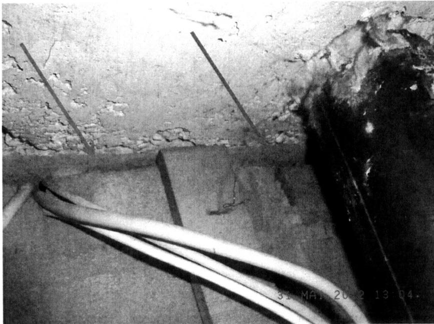
Bild 3: Keine Dichtmasse zwischen Ausfachung und Decke (Pfeile)
