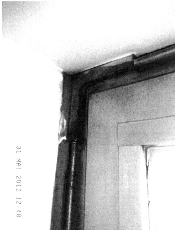
**Bild 6: Umlenkstück Fensterbeschlag**
