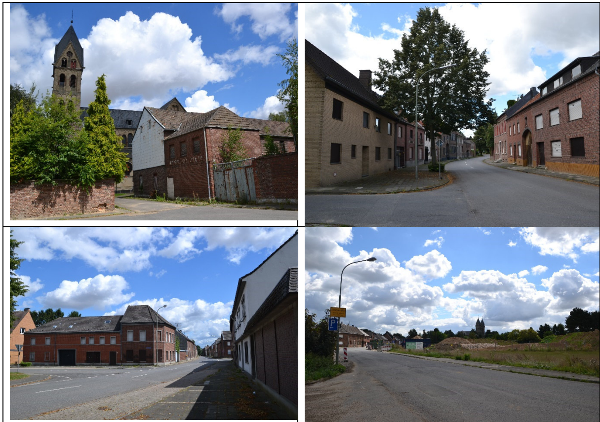
Abbildung 104: Konfliktbereich (KB) 27. Immerath, Gebäudeansichten (LVR-ABR Bodeon; NW_2016_3065_006, 002, 008, 001).
