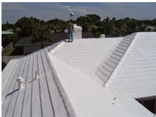
Beschichtung Dach mit Butyl | Roof Coating Orlando, https://creativecommons.org/licenses/by/2.0/ (2015)
