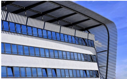
Dachlamellen als Beschattungselement der Fassade | Alexas_Fotos, https://pixabay.com/de/service/license-summary/ , (2019)
