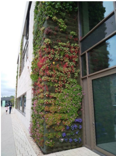
Fassadengebundene Begrünung | BPI (2021)
