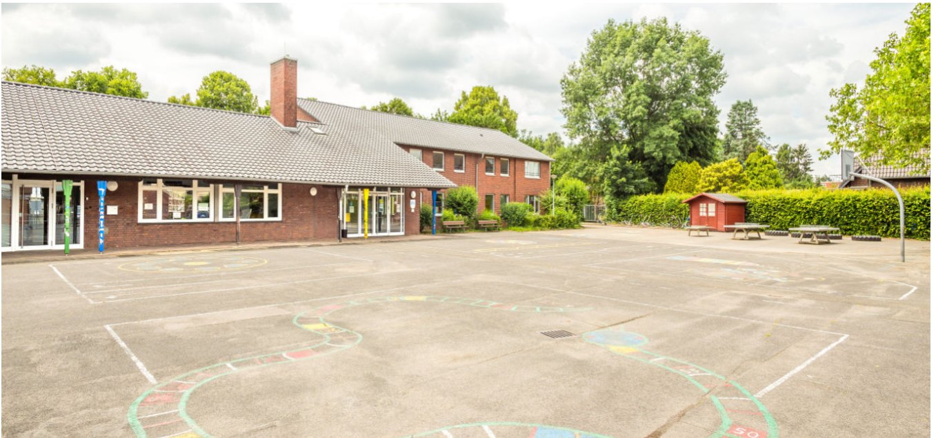
Richard-Schirrmann-Schule - Städtische Gemeinschaftsgrundschule Hoistener Schulstraße 13-15, 41469 Neuss 2-zügig
