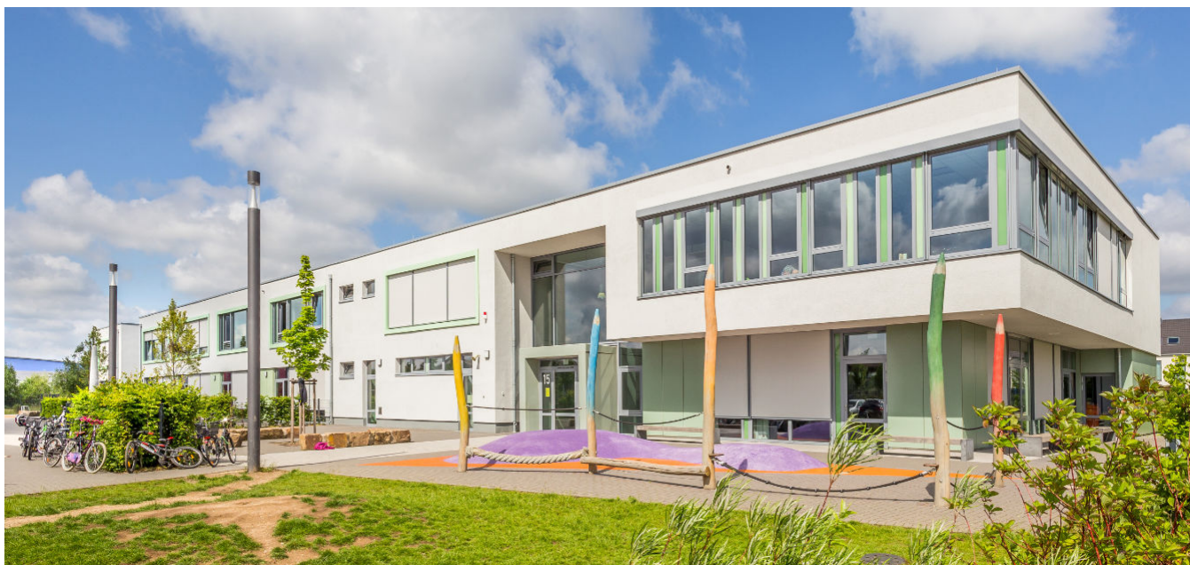
Grundschule Allerheiligen - Städtische Gemeinschaftsgrundschule Am Henselsgraben 15, 41470 Neuss 3-zügig
