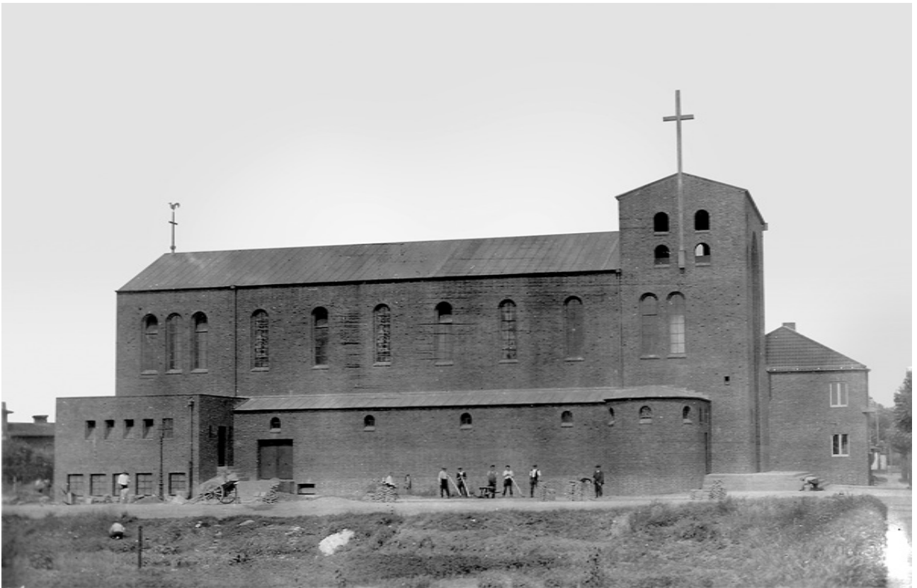
La nouvelle église Sainte-Barbara en construction, 1933
