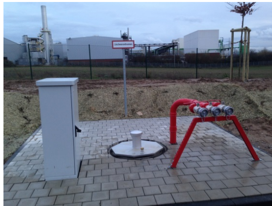
Das Bild zeigt exemplarisch eine mögliche Ausführung. Hier beispielhaft für einen Brunnen mit einer Leistung von ca. 1600 l/min.
