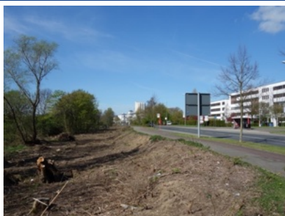
Abbildung: Bauvorbereitungen Hammer Landstraße
