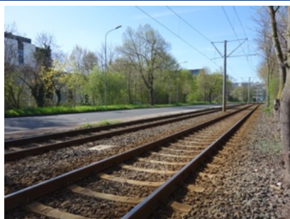
Abbildung: Gleis- und Straßenraum Stresemannallee
